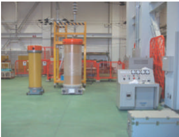
検電器試験装置
