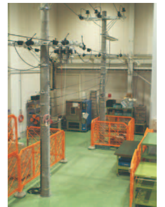
配電線模擬電柱
